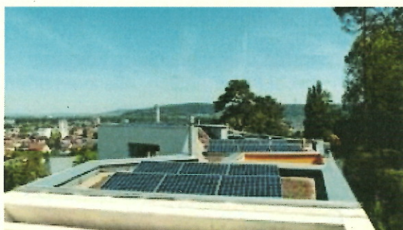
Foto: Moderne Architektur - Flachdach-Montage
