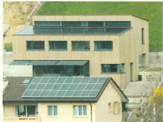
Foto: Neubau (hinten) – Indach-PV-Anlage, vorne Aufdach-PV-Anlage
