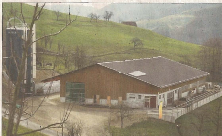
Nur 14 Quadratmeter Kollektorfläche produzieren täglich 400 Liter Heisswasser. (Bild: Ulrich Frei)
